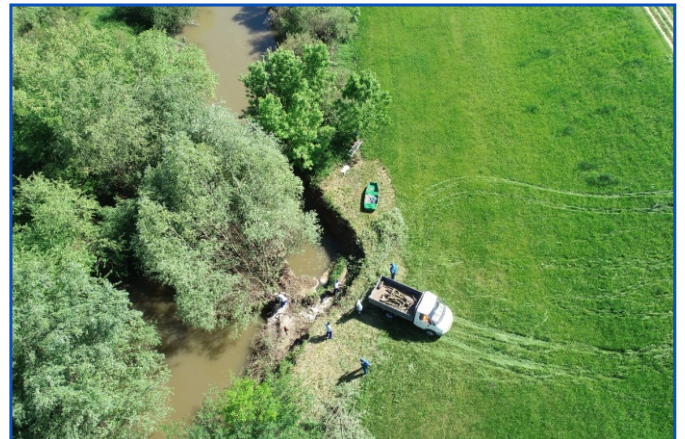
A Berettyóújfalui szakaszmérnökség munkatársai megkezdik a helyreállítást
