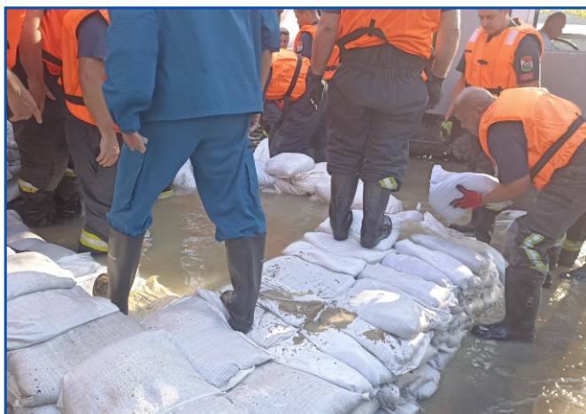
Aknából feltörő víz megfogása
