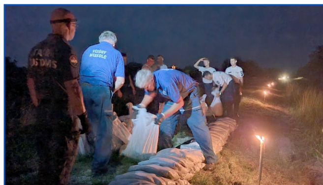
Nyúlgát építés a Rába töltésén 2024. 06. 09.
