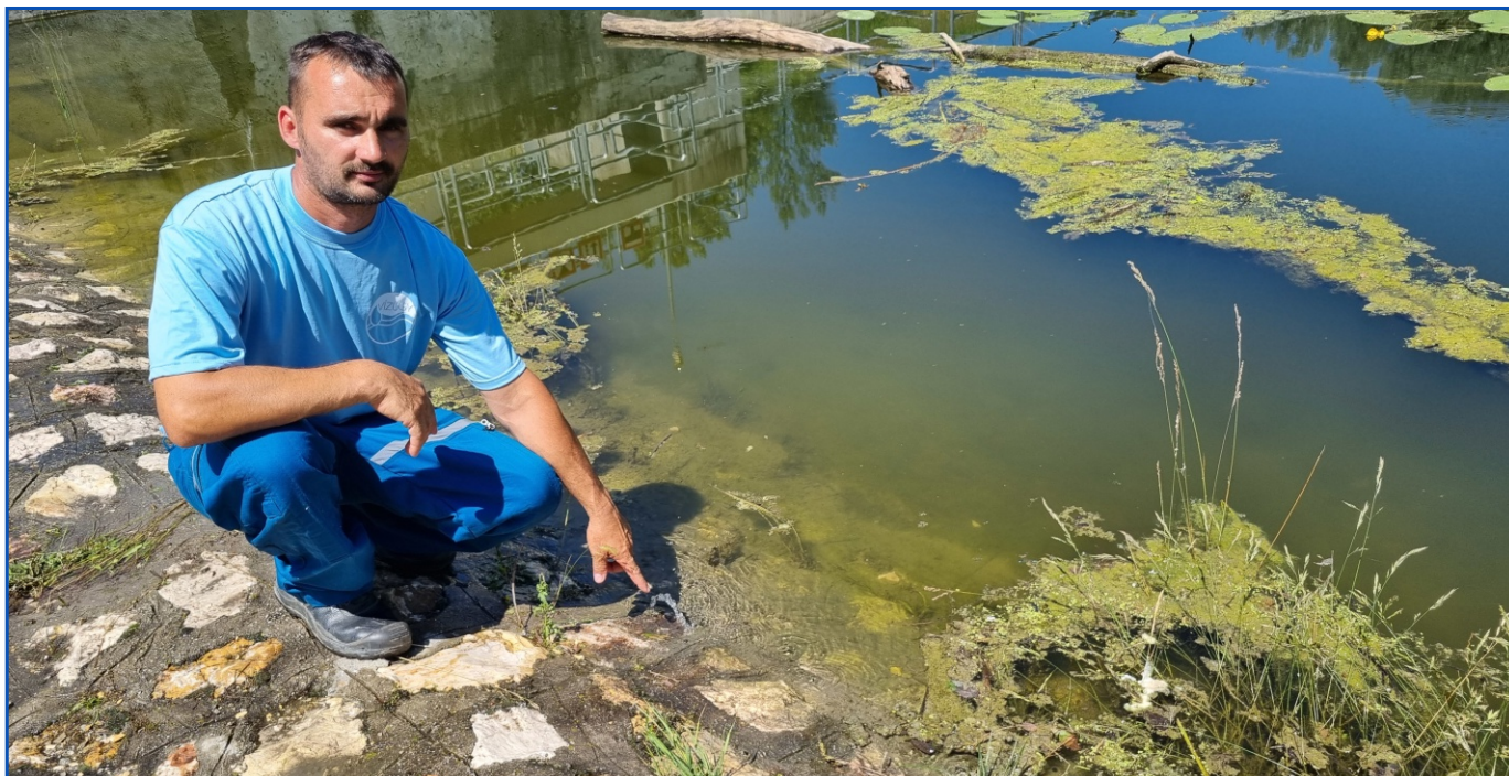
Horogh István a Hajdúszoboszlói Szakasz mérnökség csatornaöre mutat egy káros jelenséget a Püspökerdei-holtág torkolati műtárgyánál
