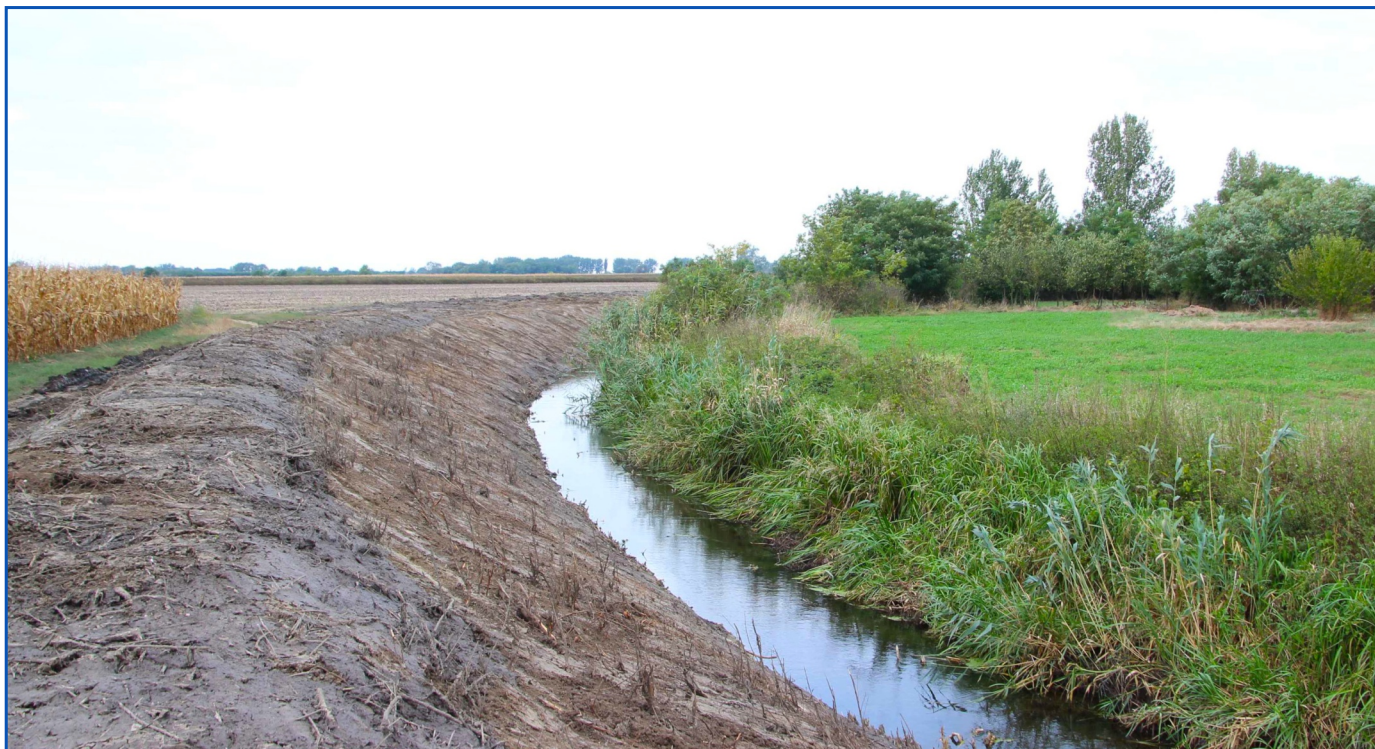
Félszelvényben megvalósult kotrás a Csente-Szakáli II. csatornán
