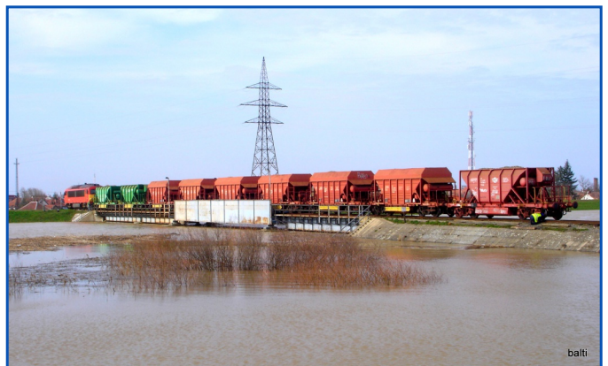
10. kép - A leterhelt szeghalmi vasúti híd 2013-ban (forrás: TIVIZIG)
