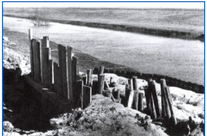
6. kép - A Kálló-főcsatorna 1+280 tkm szelvényében bekövetkezett töltésszakadás elfogása (forrás: Dunka és Papp 2008)
