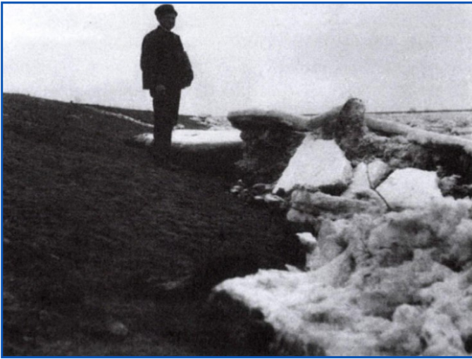
3. kép - A torlódó jég rongálja a rézsút a darvasi gátörház előtt február 9-én (forrás: Dunka és Papp 2008)
