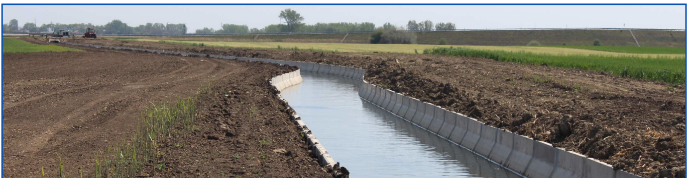
Az új burkolt meder a Derecskei-főcsatornán
