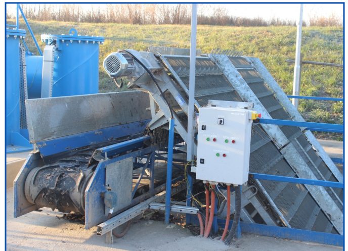
Két új mozgógereb a szivattyútelepen
