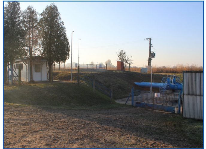
A felújított szivattyútelep, új kezelőépülettel
