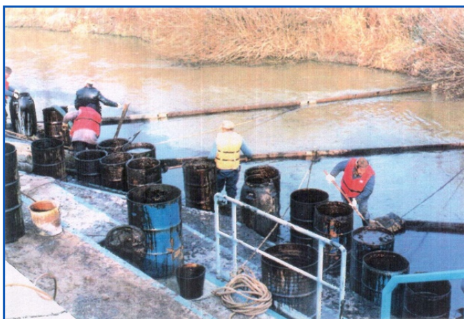
Az összegyűlt olaj leszedése cserpákkal
