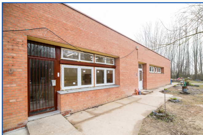
A kezelőépületet is felújítják
