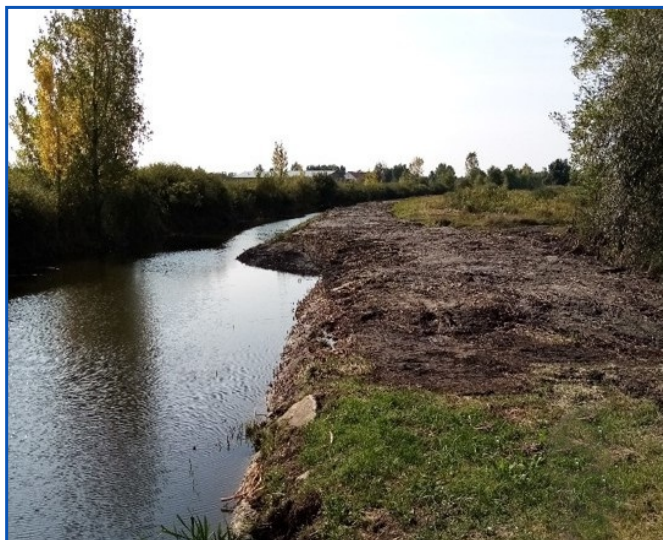
Nagyfok-csatorna kotrás után
