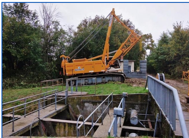
K-V-3 fővízkivételi műtárgy felújítása
