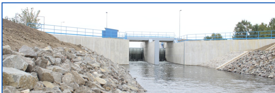
A Keleti-főcsatorna újjáépített vízleadó zsilipe Bakonszegnél
