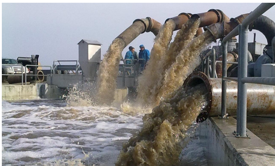
Az Ágotai vészlezáró lezárása után ideiglenes szivattyúk segítségével emelték át a TIVIZIG szakemberei a Hortobágy-Berettyó vizét a Nagyiváni tározóba.
