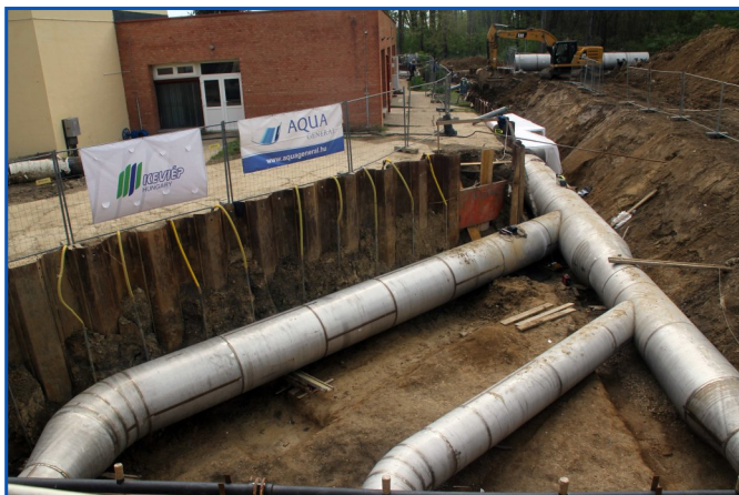
Épül az udvartéri vezeték a HTVR szivattyútelepen
