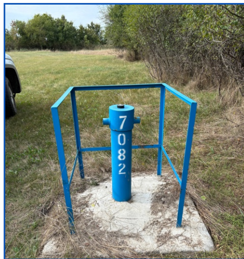
Balmazújvároson 2023-ban a KEHOP 3PE projektben épült talajvíz figyelőkút
