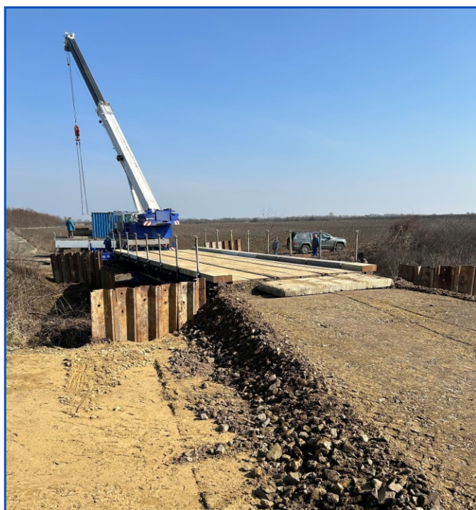
2. kép: M-49 gyorsforgalmi út 27+000 km szelvényében telepített mobilhíd
