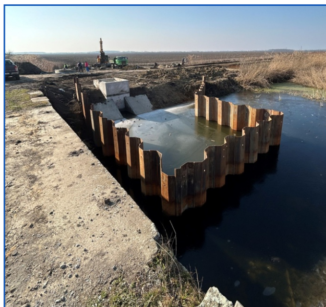
3. kép: Daruzugi öntözőtelep vízkivételi műtárgy kivitelezéséhez szükséges szádlemezes munkatérhatárolás
