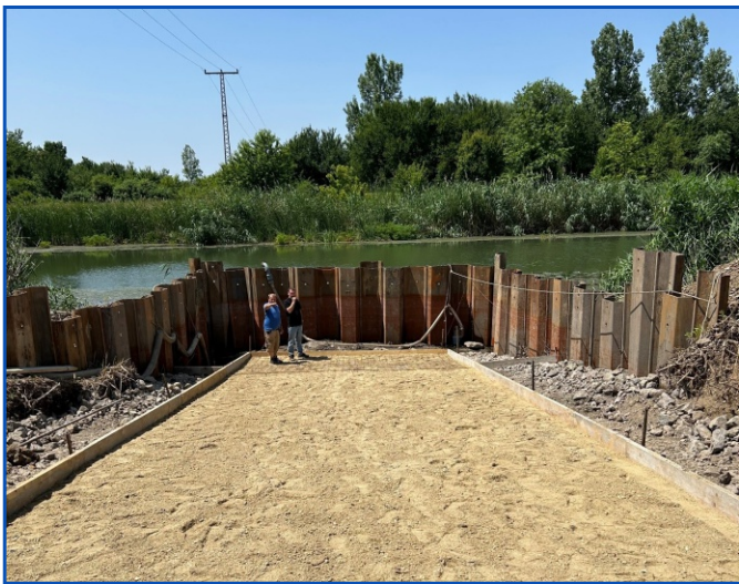
4. kép: Keleti-főcsatorna 66+367 szelvényénél sólyapálya kivitelezése
