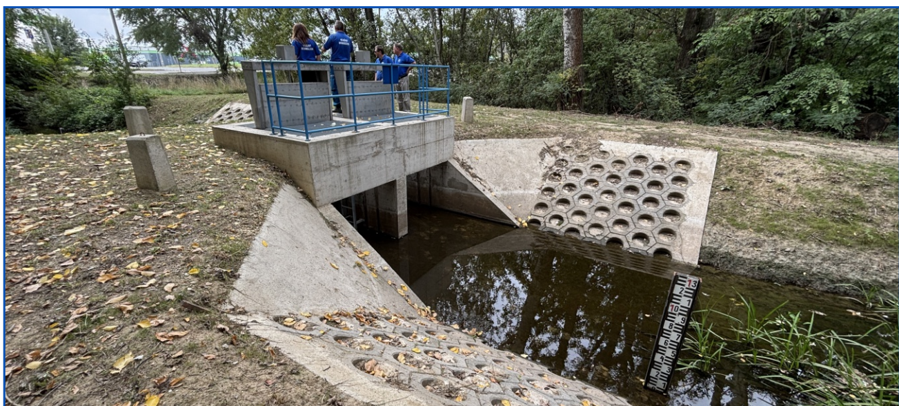
Szemlebizottság a Tóció-csatorna D15a műtárgyánál
