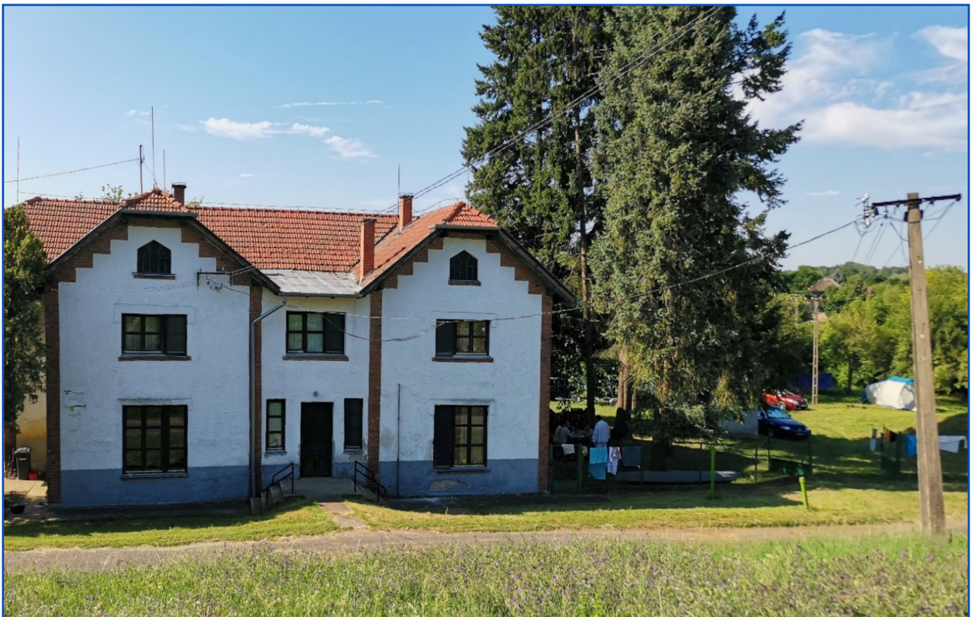
A Tiszafüredi szivattyútelep épülete
