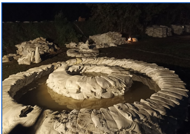
Épület melletti buzgár bevédeése éjszakai fényben
